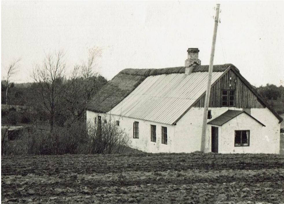
Huset er ved at blive moderniseret. Henry har monteret nye pandeplader på dele af taget. Henry har skaffet dem fra brandstationen i Rantzausgade i Aalborg. Foto 1964.
