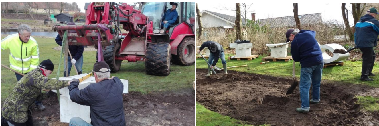
Frivillige fra Samrådet, Villy Aagaard Nielsen, Palle Nørskov, Jon Kjeldgaard, Torben Hedemann Jensen, Thorkild Dahl Pedersen, og Poul Dahl, arbejder på at få betonkreationer på plads ved gadekæret. Fotograf Ole Schwarz og Poul Dahl.
